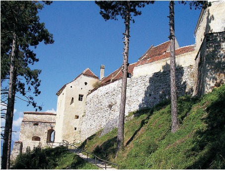
Fig. 1. Exterior de la fortaleza por el lado norte.
