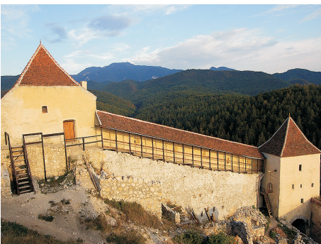
Fig.3. Parte este de la muralla.
